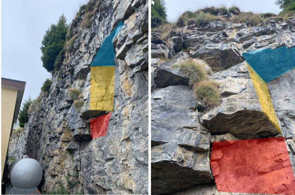
Abbildung 4: Ansichten der Felsanschnitte hinter dem Bahnhofgebäude; Hauptsächliche Trennflächen: blau = Schichtung; rot = unregelmässige hangparallele Klüftung, bzw. Sprengfläche; gelb = vertikale Hauptklüftung (NW-SE streichend)
